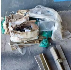
Os engradados (principalmente o pallet de motor/painel) estavam armazenados corretamente ao abrigo de sol de chuva? Em casos onde não é possível acessar o local de armazenamento, análise se estão com alguma marca de umidade ou as caixas em mal estado.
