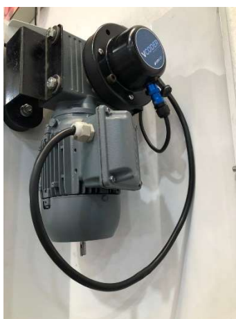
Figura 4 - Haga las curvas del cable para que salga del motor, no dentro.
