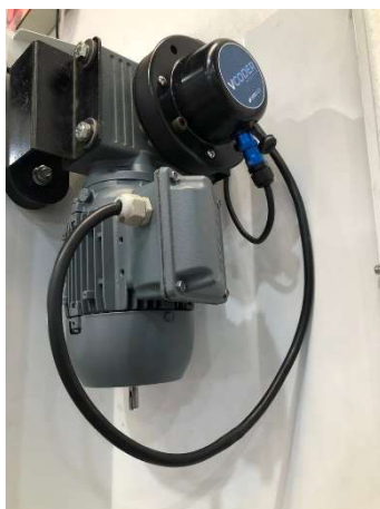
Figura 4 -Fazer as curvas do cabo de forma a escorrer para fora do motor, e não para dentro.
